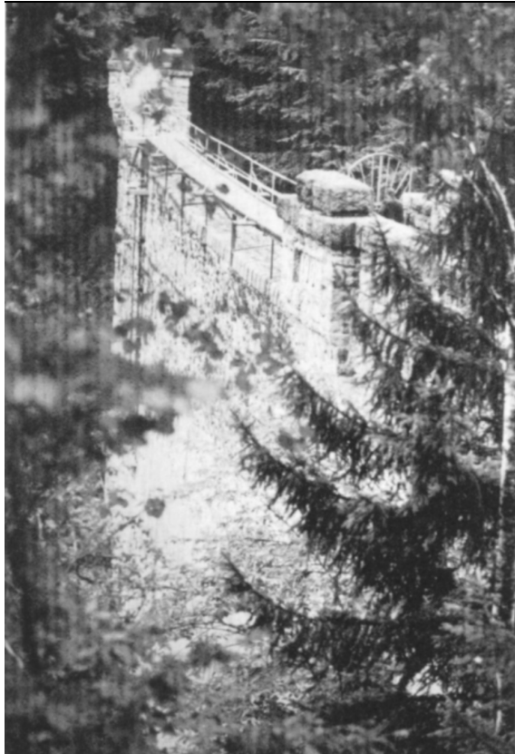
Zapora z kładką nad koroną tamy. Gdy zbiornik był pełen, a przez koronę tamy przelewała się woda, dzięki drewnianej kładce można było przejść przez mur zapory suchą nogą
