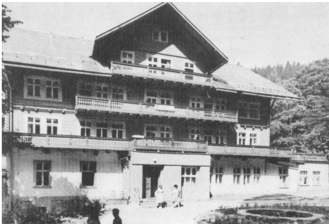
Hotel „Forelle” (Pstrąg) w Międzygórze nad Wodospadem Wilczki
